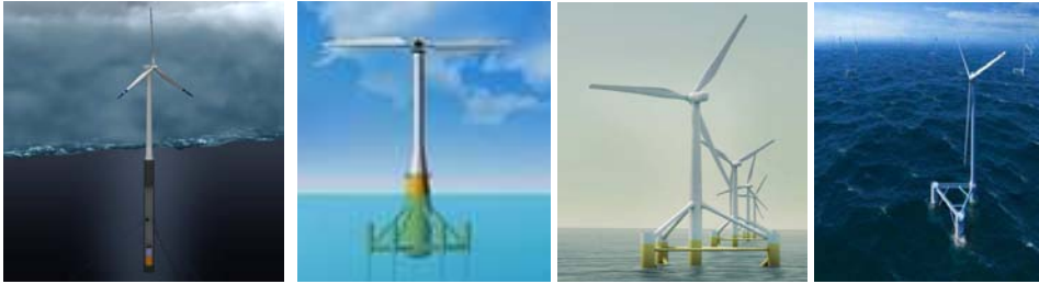
Figures 12 à 15. Les prototypes Hywind, Diwet (Blue H), Winflo et WindFloat.
